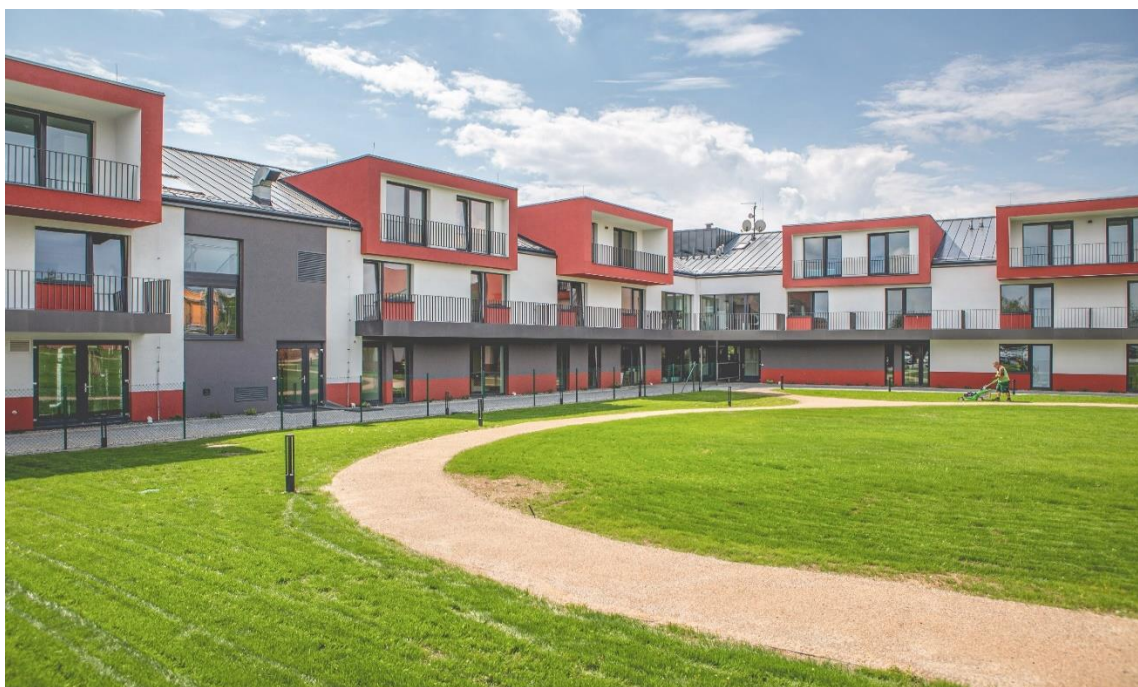
Budova sociálně zdravotnického zařízení ve vlastnictví AC IMMO s.r.o. v Černošicích
