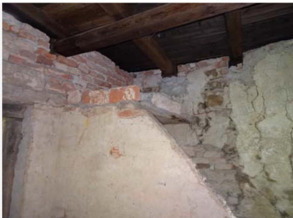
Interiér, v 1.NP
