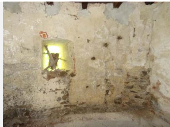
Interiér, v 1.NP
