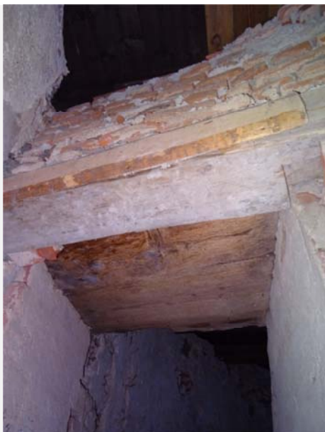
Interiér, v 1.NP
