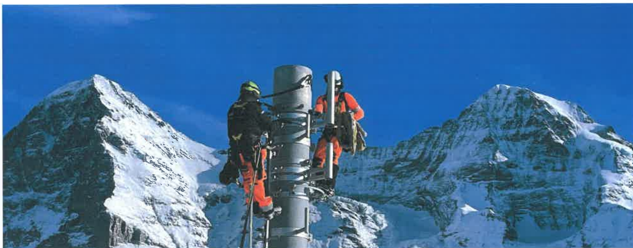
Instalace telekomunikační věže ve Valais, Švýcarsko
